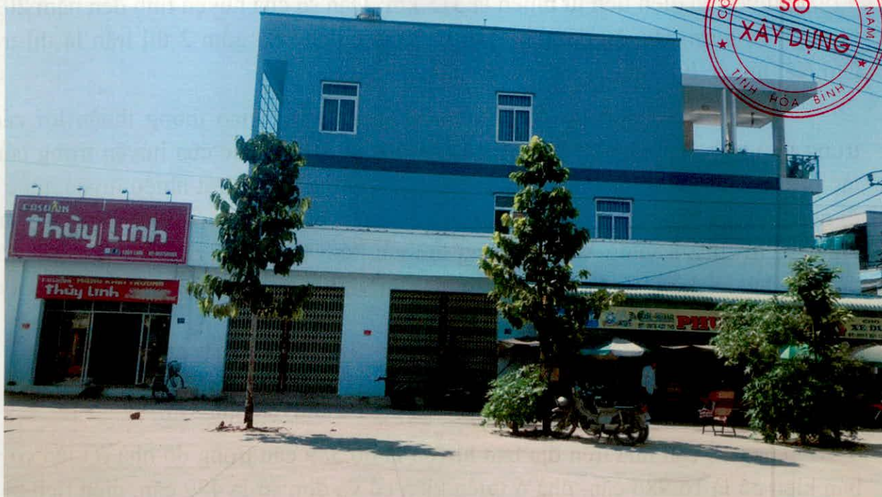
Nhà ở tại khu vực đô thị huyện Yên Thủy
