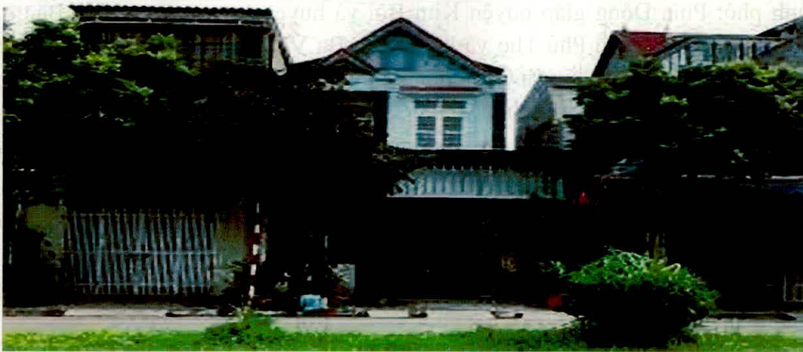
Nhà ở mặt phố, Thành phố Hà Bình
